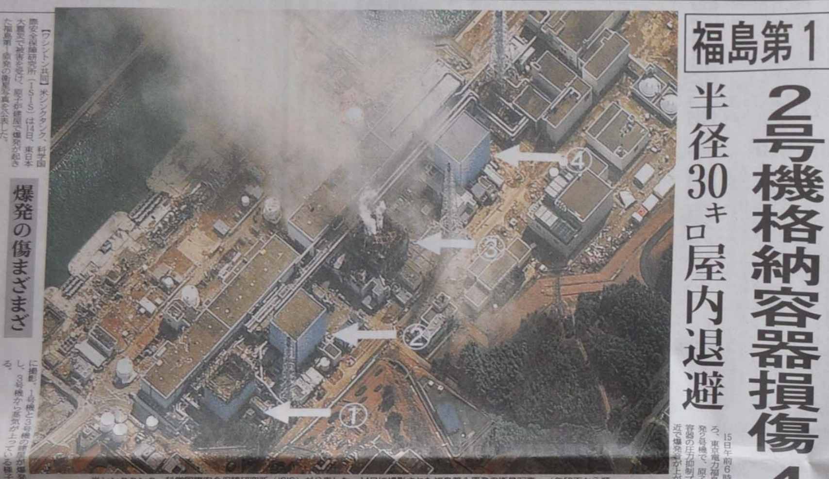
14日に撮影された福島第1原発の衛星写真。12日の爆発で破損した1号機、15日に爆発音が確認された2号機、14日の爆発で建屋が損傷した3号機。上は4号機（デジタルグローブ・ISIS提供・共同）
